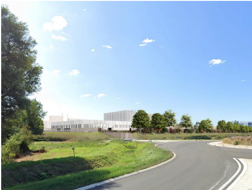
Vue aérienne depuis la route Sud
